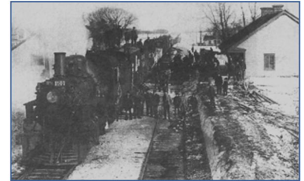
Transport de roches pour la construction du quai de Sainte-Angèle entre 1920 et 1930.
