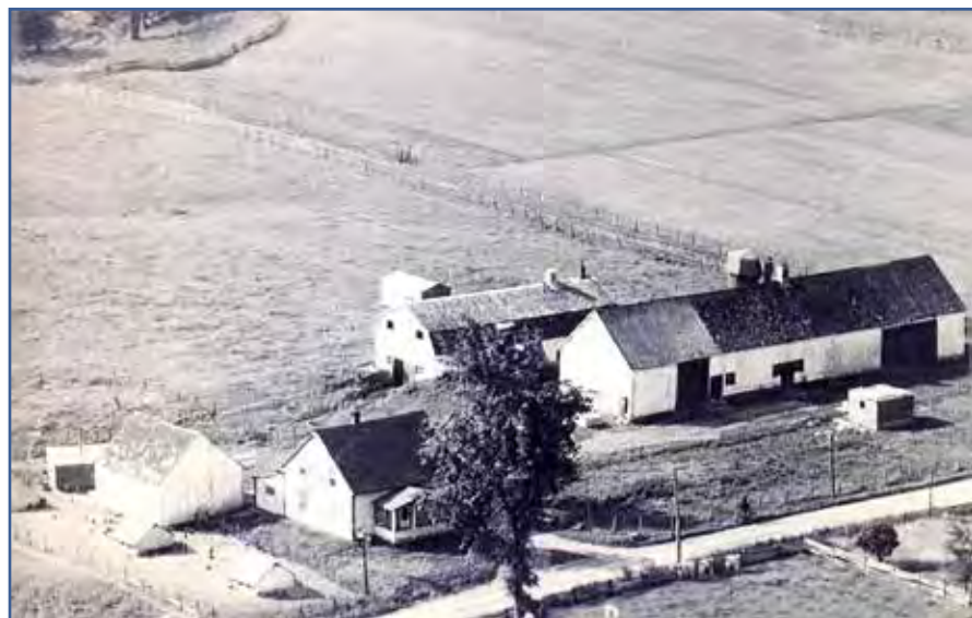
Ferme de Maurice BERGERON dans le haut du rang 8 en 1955 Autrefois celle de Gédéon Hélie (partie ouest du lot 157).
