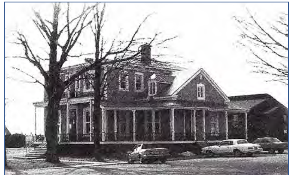
Le presbytère après sa rénovation en 1985.
