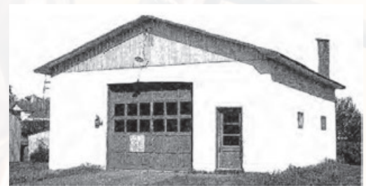
Garage municipal construit sur la rue Richard vers 1963
